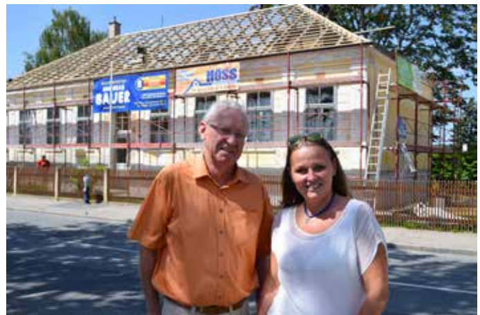
Ortsvorsteher Alois Burger und Familienstadträtin Maria van Dyck freuen sich über ein neusaniertes Gebäude, wo die Kindergartenkinder nun weiterhin sicher betreut werden können.
