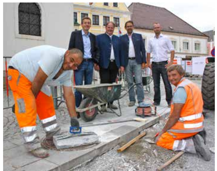
Ein Bild von den Umbauarbeiten wo Hassan Oruc und Erwin Kainz Granitsteine verlegen, an die der Asphaltbelag auf gleichem Niveau angeschlossen wurde. Bgm. LAbg. Jürgen Maier, Baustadtrat Manfred Daniel, GR Paul Klingler und Mario Don beim Lokalausgesehen.
